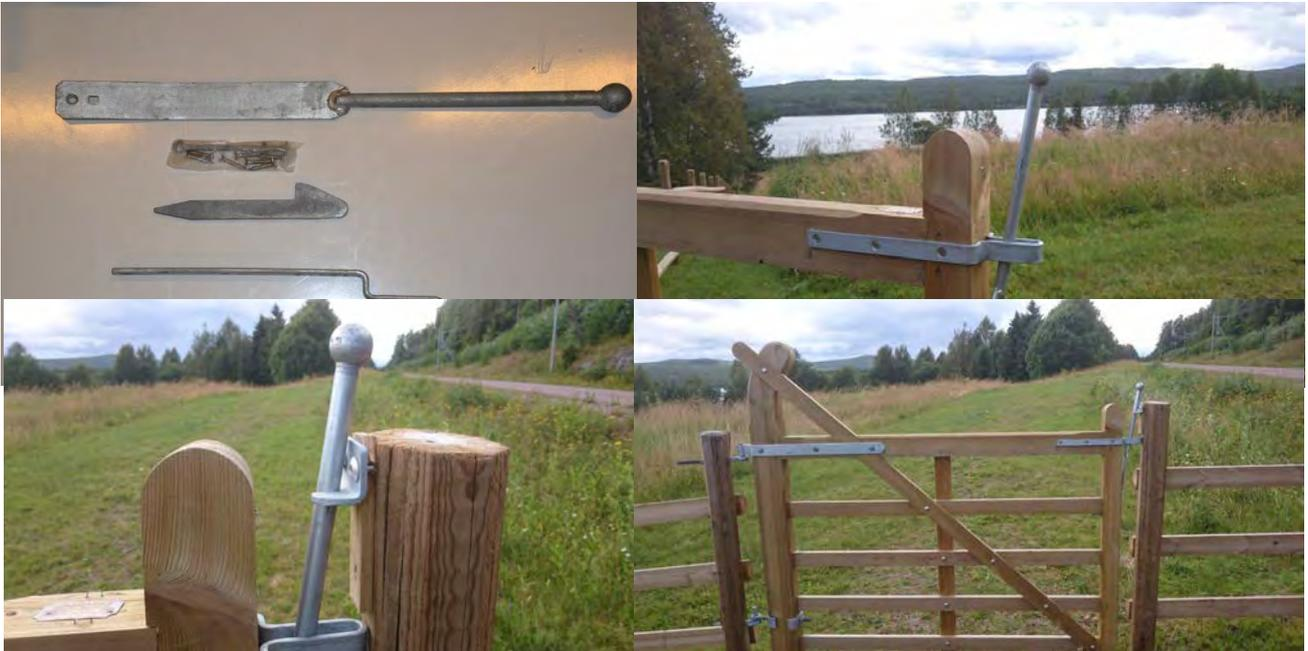
Der Bodenschieber wird wie auf der Abbildung dargestellt montiert. Bitte beachten Sie: Je höher die Bodenfreiheit des Tores ist, desto tiefer muss der Bodenschieber am Tor angebracht werden, damit der Schieber tief genug in den Boden eindringen kann. Öffnen Sie das Tor bis zur gewünschten Position und graben Sie die Bodenhülse so ein, dass sie ebenerdig abschließt und sich direkt unterhalb des Schiebers befindet.
